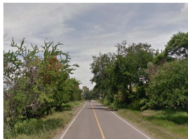
IMAGEN QUE EXPRESA LAS CONDICIONES FISICAS EN BUEN ESTADO DEL PAVIMENTO EN LA VIALIDAD/VR CARRETERA MAZAMITLA-TIZAPAN EL ALTO.
