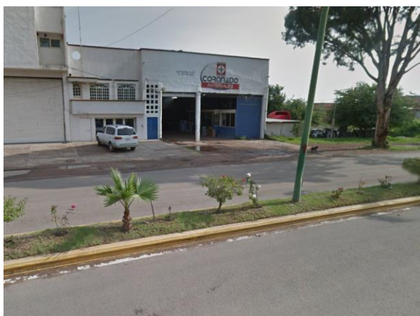
IMAGEN QUE EXPRESA LAS CONDICIONES FISICAS EN BUEN ESTADO DEL PAVIMENTO EN LA VIALIDAD/VR CARRETERA A MORELIA.
