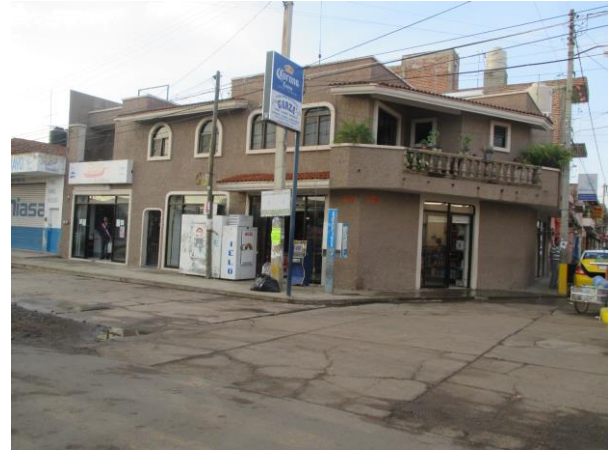
IMAGEN QUE EXPRESA LAS CONDICIONES FISICAS EN REGULAR ESTADO DEL PAVIMENTO EN LA VIALIDAD/VP NACIONAL-OTE. Y GUERRERO.
