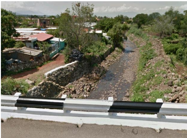
IMAGEN DEL CUERPO DE AGUA EXISTENTE EN CARRETERA MORELIA-GUADALAJARA EN LA LOCALIDAD VILLA EMILIANO ZAPATA, TIZAPAN EL ALTO, JALISCO
